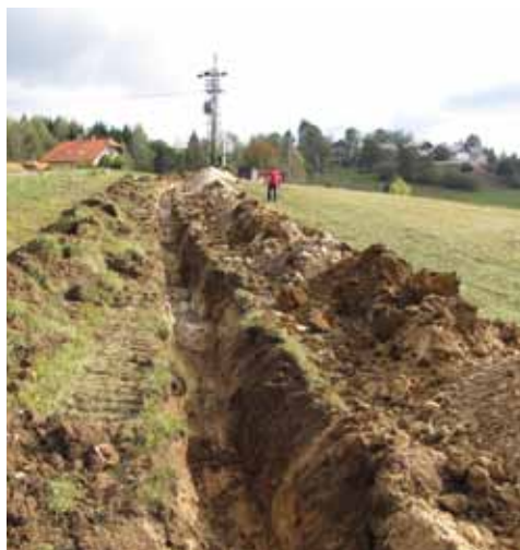
Povezava vodovoda Strmca z javnim vodovodom
