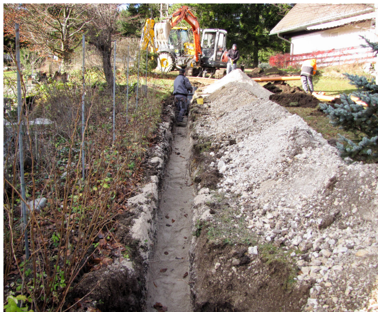
Izgradnja skupnega kanala med vikendi na Volčjem
