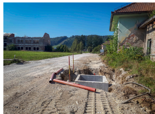
Izgradnja elektroomrežja v coni Velike Bloke
