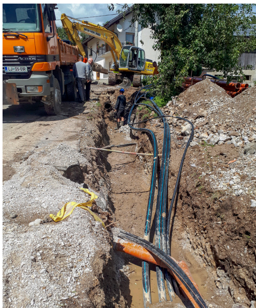
Vgradnja vodovodnih, kanalizacijskih in telekomunikacijskih cevi v naselju Veliki Vrh
